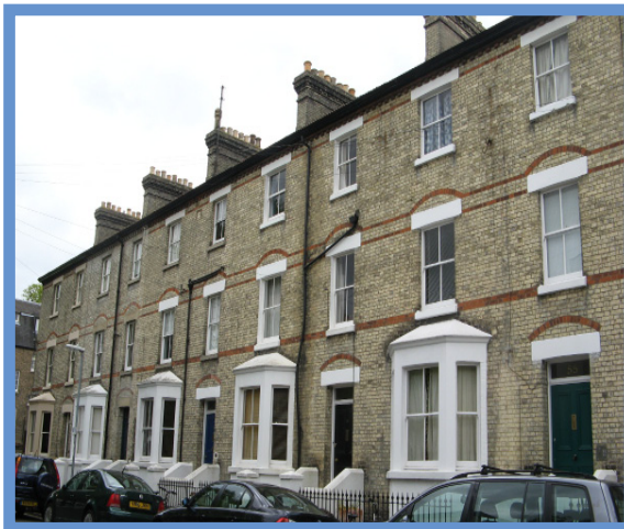
Nos. 51-59 Warkworth Terrace
