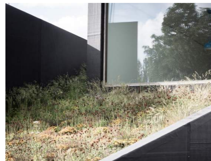
Biodiverse Green Roof - House Pibo, OYO
